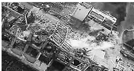
水素爆発で建屋が吹き飛んだ福島原発1号機(2011年)
