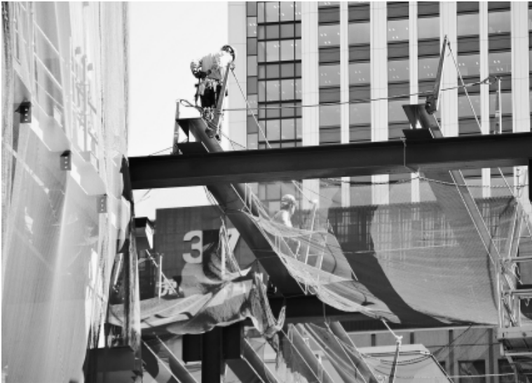
虎ノ門の再開発現場
