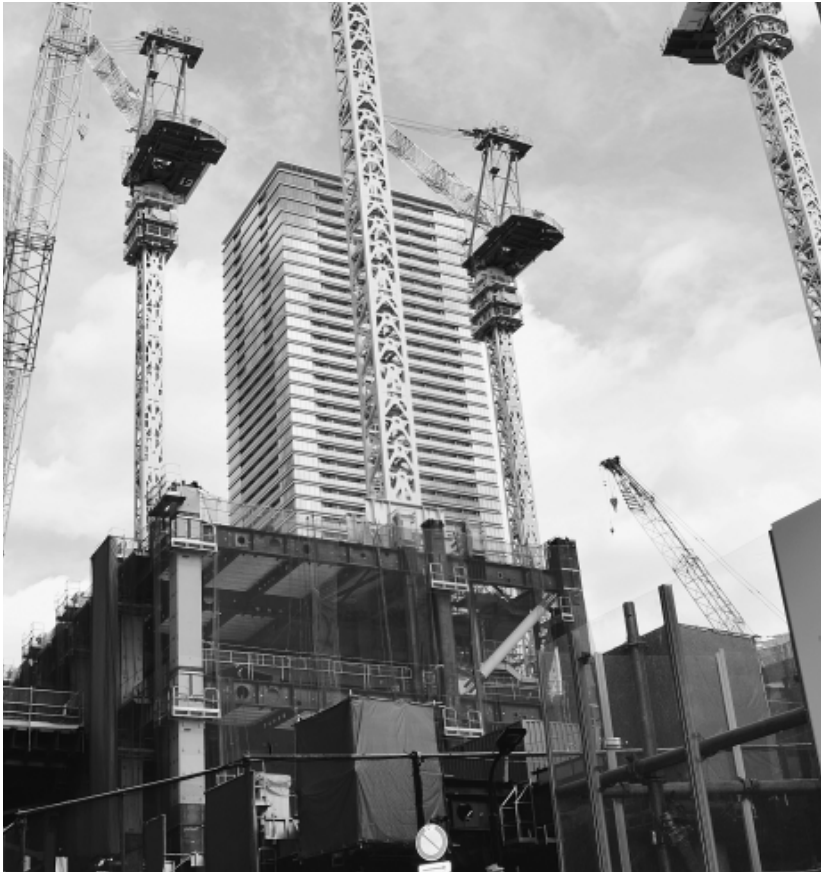
再開発が進む虎ノ門地域の現場
