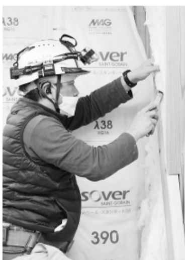
隙間なく断熱材を詰めていく北村さん
