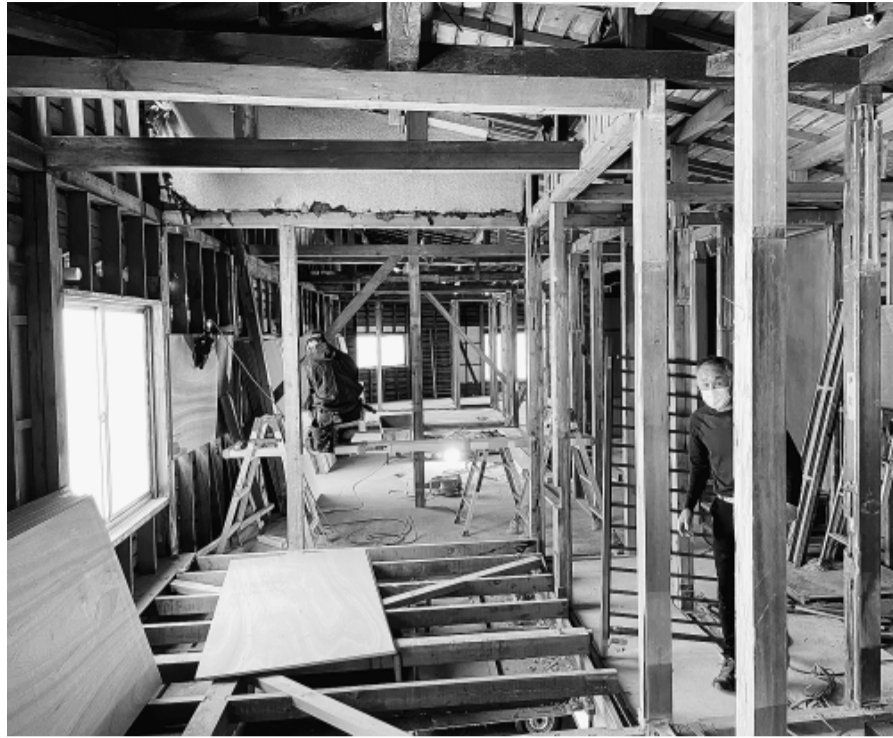
施工中の(株)OKURIシーズ44・大内亮さん
