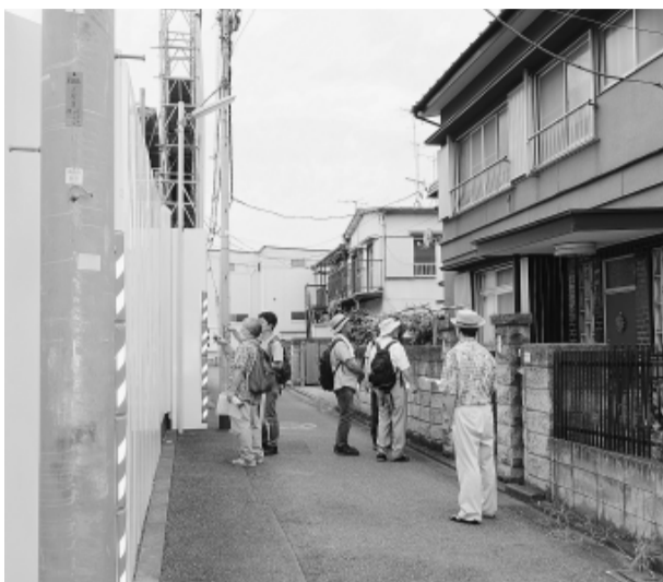
住宅街に隣接している現場を視察
