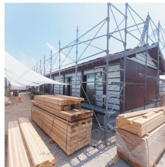
宇城市で建設中の応急仮設住宅
