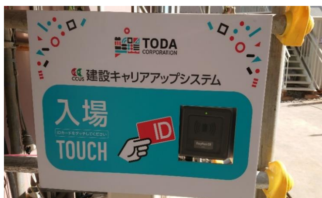
戸田建設の現場でカードリーダー設置
