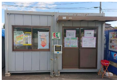
リーダーが設置された現場入口の休憩所
