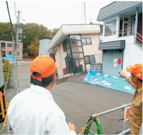
札幌市清田区里塚地域の地盤沈下現場を視察
