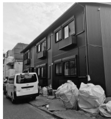
死傷したベトナム人作業員が発見された現場
