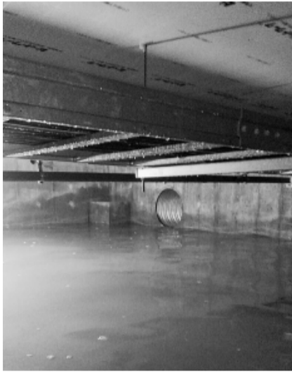
ピット内は高さが1.5m程。腰を屈めての作業になる
