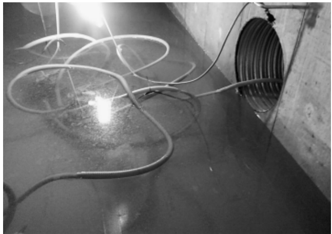
濁った水が溜まっている
