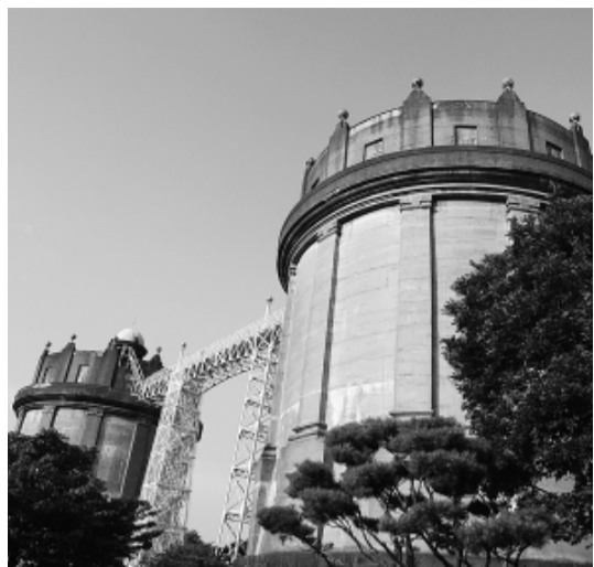
大正ロマンを感じさせる配水塔 (写真提供：駒沢給水塔風景資産保存会)
