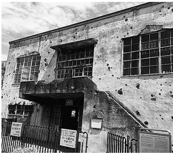
変電所の外壁には機銃掃射の弾痕が残る
