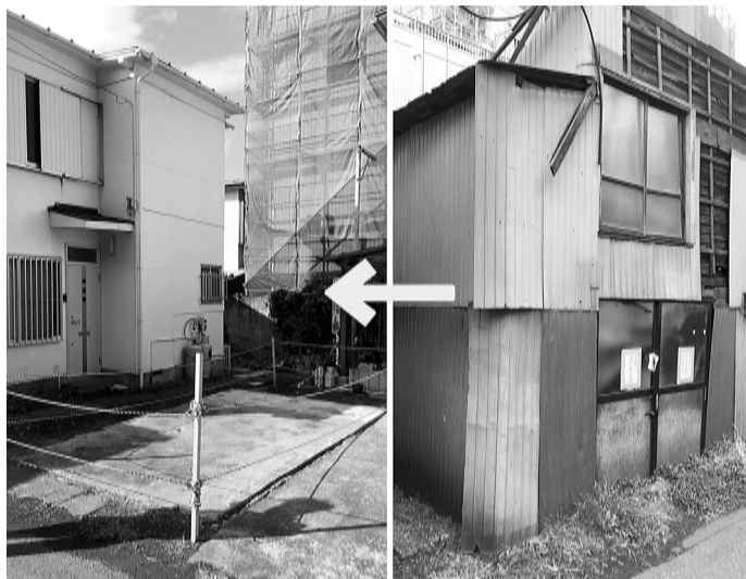
特定空家を解体撤去する前（右）と後
