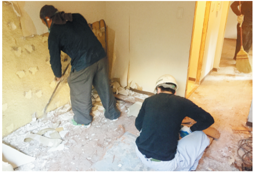
32軒の地下室の解体工事を行なった
