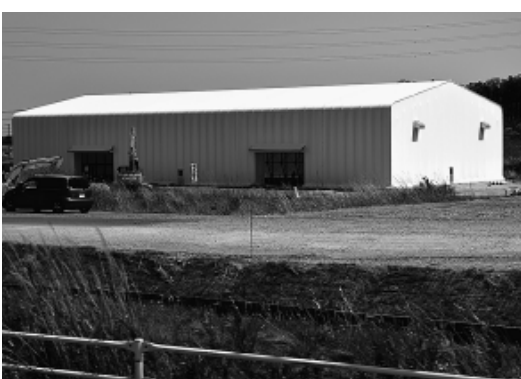
フクイチ近くで建設中の中間貯蔵施設
