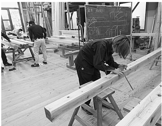
木造軸組みの2階建てを建てる「実習棟実習」授業の様子（写真手前は益永真理子さん）
