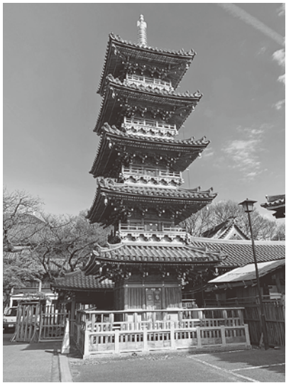
昨年建立された木造五重塔
